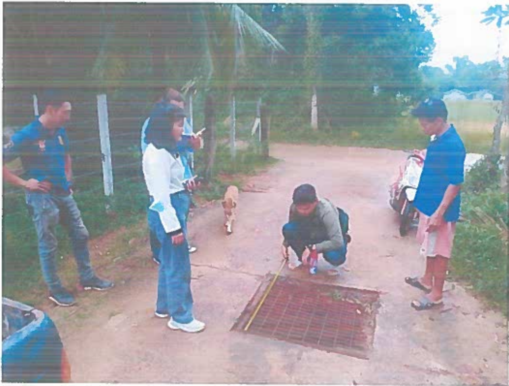
ภาพถ่ายฝาดะแกรงเหล็กที่ชำรุด
