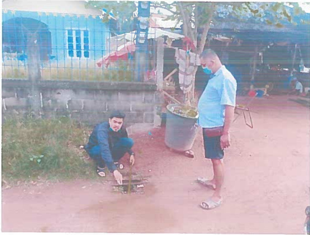
ภาพถ่ายฝาดะแครงเหล็กที่ชำรุด
